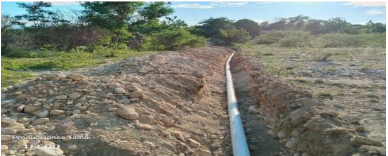
Obra Mejoramiento Suministro de agua potable Hato Nuevo. El Proyecto PPM 2025
