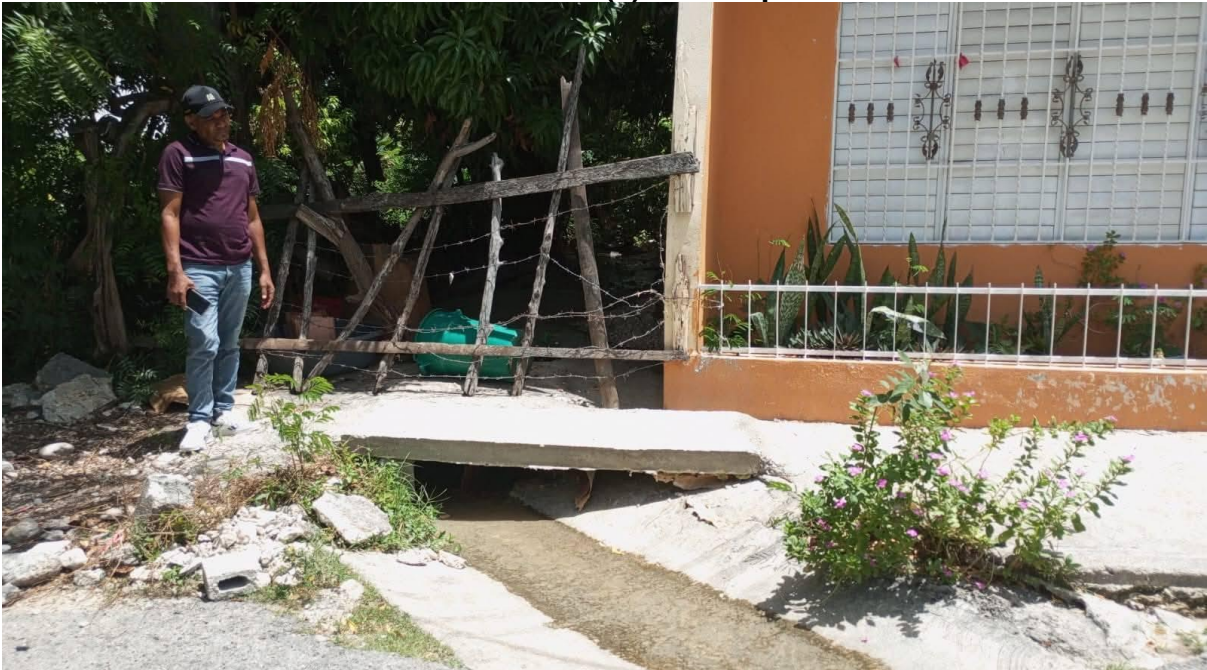
Puente Peatonal en la calle circunvalación
