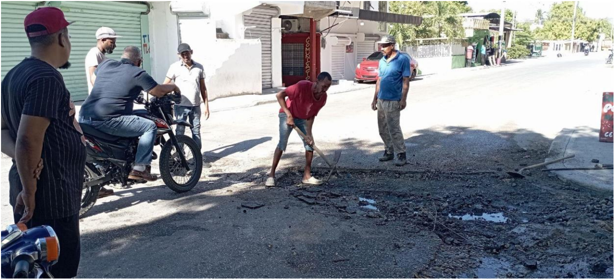
Segunda Reparación de Baden, en la avenida las viñas (Materiales y Mano de Obra)
