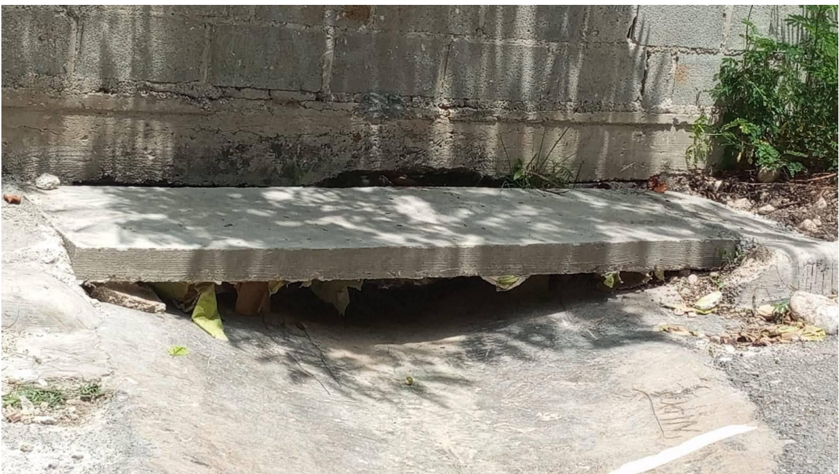
Construcción puente peatonal Arriba de la casa de benjamín Sena
