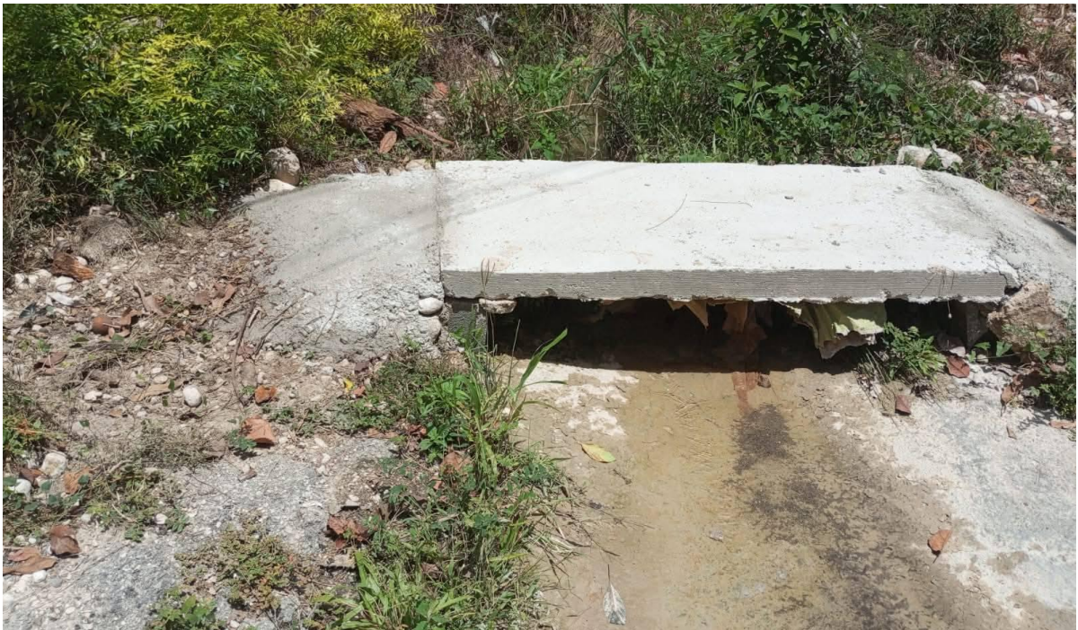
Construcción puente peatonal frente de la casa de Bartolina
